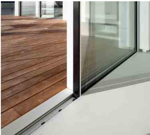
Абсолютное отсутствие препятствий перемещению за счет установки конструкции вровень с полом
